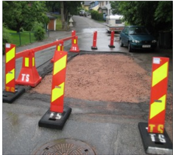
Sikring av gravested.
