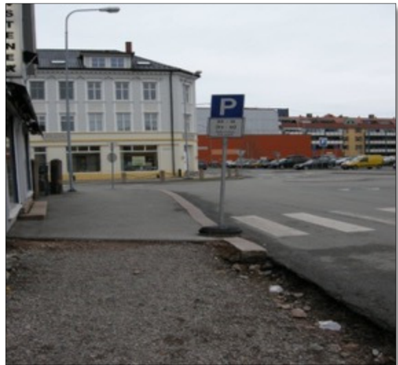
Manglende avsperring av arbeidssted.
