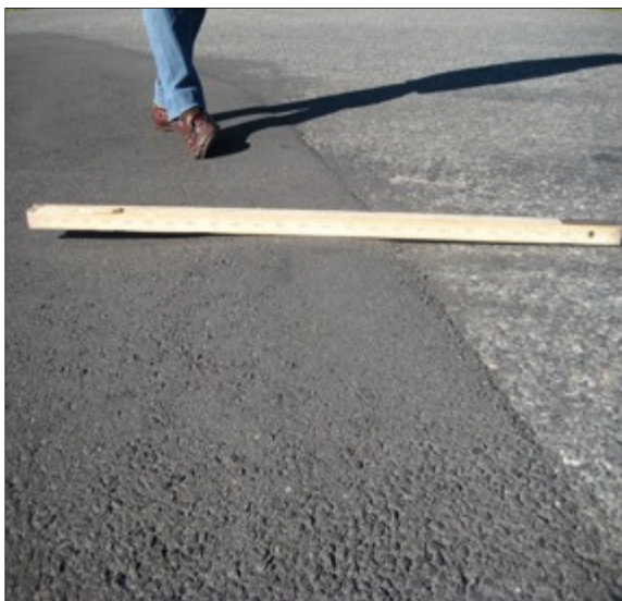
Nivåsprang mellom nytt og gammelt veidekke
